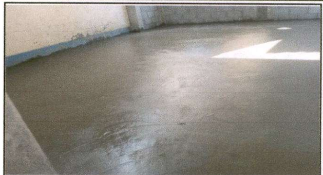
Foto 2: Sustitución de piso de tierra por cemento (patio, modulo 2)
