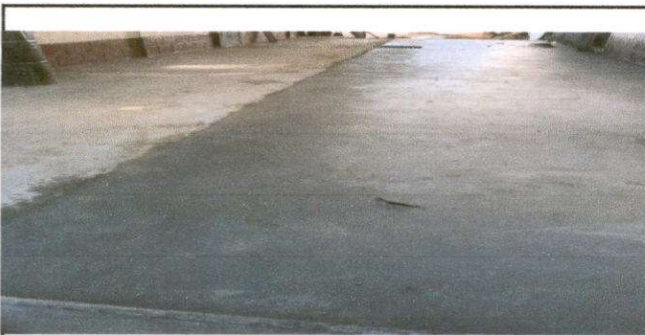
Foto 3: Sustitución de tubería PVC línea principal de aguas negras
