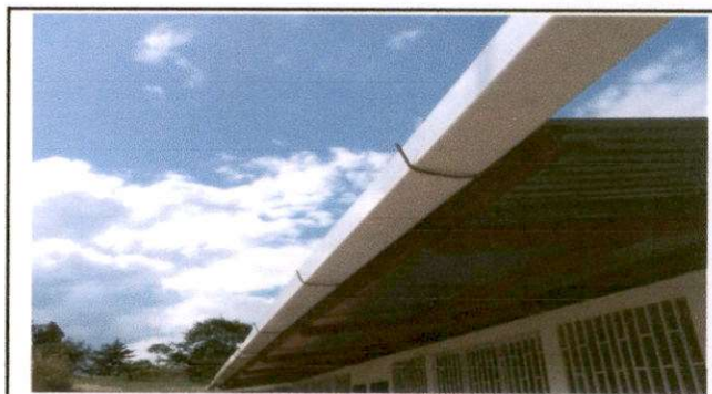
Foto 4: Sustitución de canal de PVC (Modulo 1)
