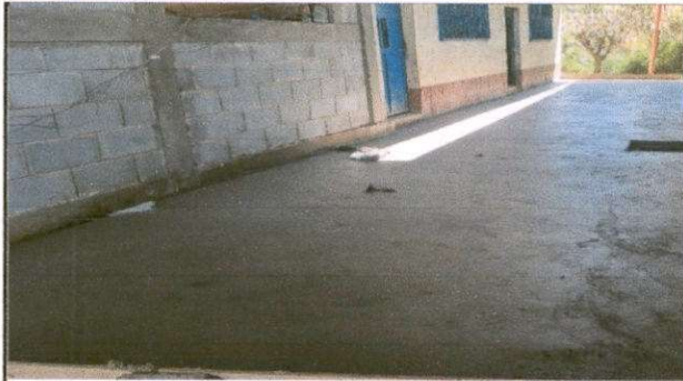
Foto1: Sustitución de piso de tierra por cemento (patio, modulo 1)
